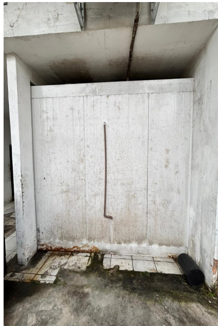
Figura 5: Imagem Lateral da câmara frigorífica
