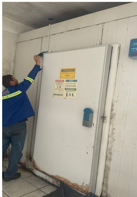
Figura 4: câmara não mantém a temperatura de congelamento
