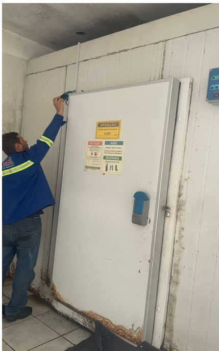
Figura 2 Porta aquecendo e passando descarga elétrica
