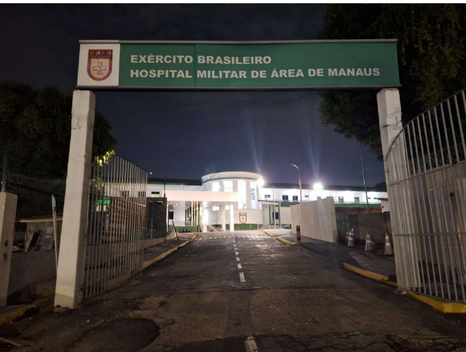
Item 03 - PÓRTICO FRENTE NOITE (Entrada Principal)
