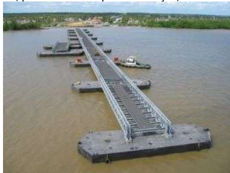
Ponte LSB flutuante
