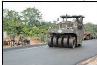
Rolo Compactador de Pneus
