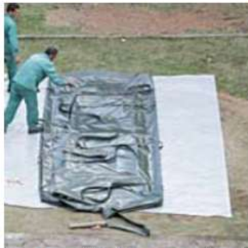
Colocar o reservatório totalmente aberto em local plano e protegido de objetos que possam danificar o equipamento.
