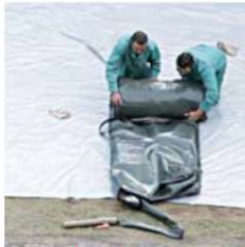
Dobrar o reservatório a 1/3 pelo comprimento e enrolá-lo totalmente.
