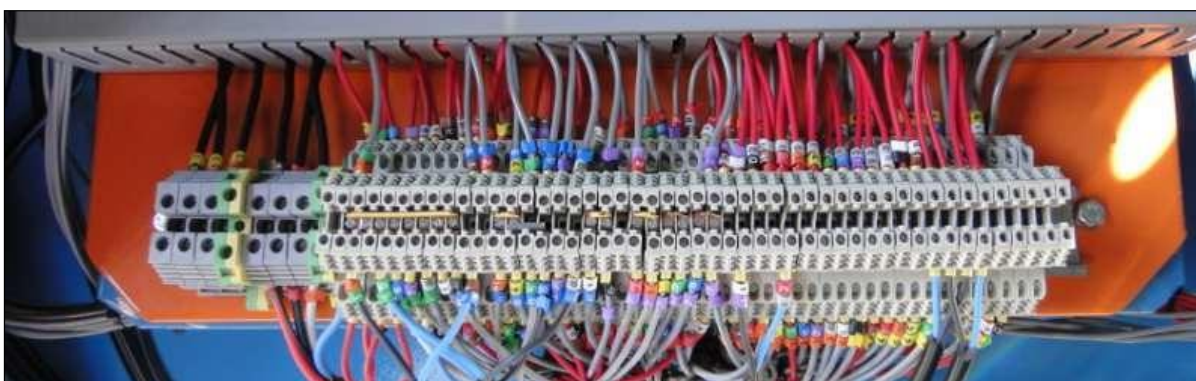
(Foto: Bornes de ligação da máquina)
